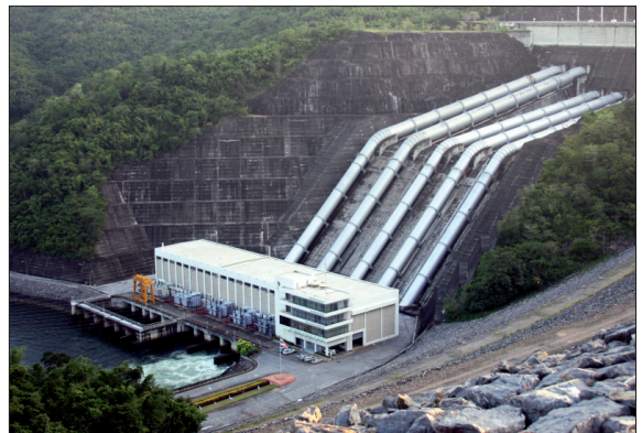
Elektrownia wodna szczytowo-pompowa na rzece Kwai w Tajlandii
