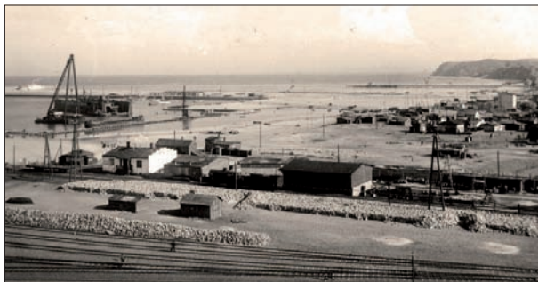
Budowa portu i miasta Gdyni.
